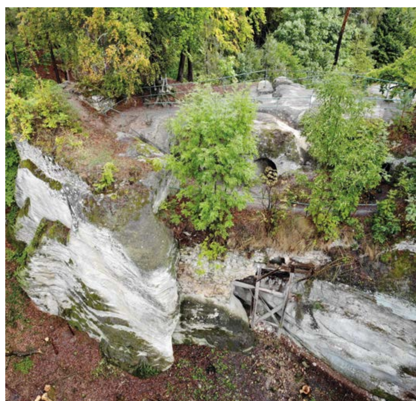
Skalní hrad Pařez, kde došlo ke kolapsu jižní obvodové hradby (zdroj: Jiří Unger).
