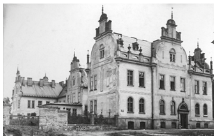
Budova chorobince (Sbírka RMaG v Jičíně).
