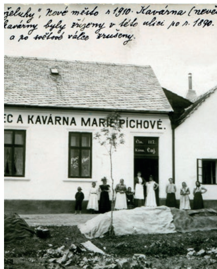
Hostinec a kavárna Marie Píchové č. p. 117 v ulici Pod Koželuhy, 1910, foto A. Brožek.
