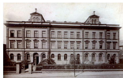
Nová gymnaziální budova postavená v letech 1881–1883 v Jiráskově ulici. Foto Josef Pícek, sbíрка RMaG v Jičíně.
